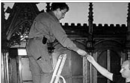
Reinigungsarbeiten nach den Ausbesserungen in der Kirche Foto: T. Rindler
